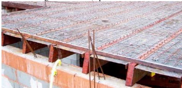
Figura 7 - Estrutura mista de laje de concreto moldada in loco nas vigas de madeira, apoiadas no muro de alvenaria
